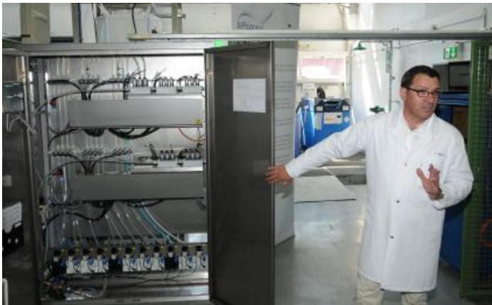
Die neue computergesteuerte Dosierung der Waschmittelkomponenten pro Wäscheposten (Charge) verhindert Fehldosierungen und verbessert die Waschqualität.
